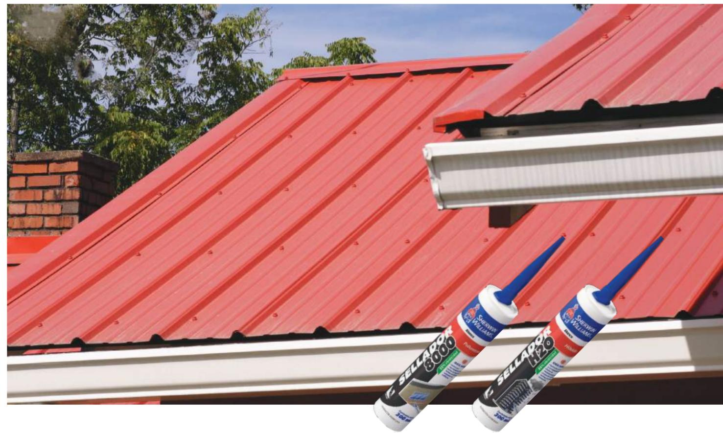
Consiste en la aplicación de sellador en juntas, uniones y puntos de fijación de las láminas. Este sistema se utiliza para prevenir filtraciones de agua y aire, garantizando la impermeabilidad y protegiendo la estructura de daños por humedad.
